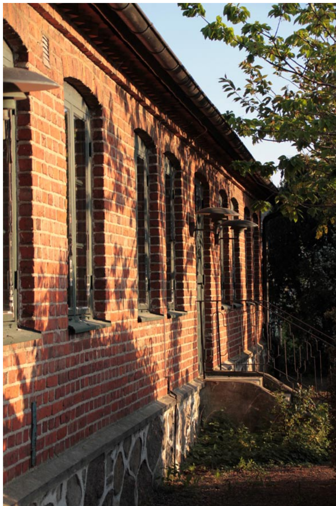
Mönstermurad tegelfasad med hundtandsgesims längs takfoten. Stickbågade fönstervalv. Synlig gråstensfot.
