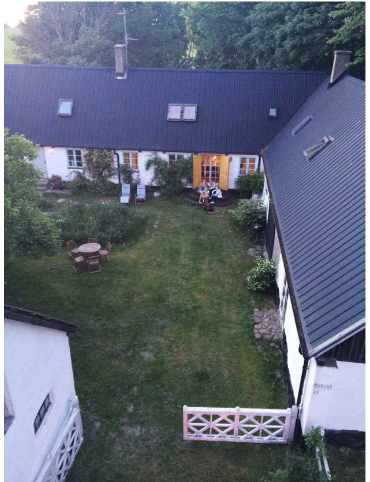
Spröjsade fönster. Takbjälkar och trägolv.
