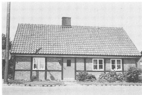
SÖVESTADBY 1:15, hus A
